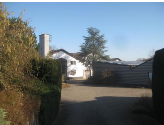
Abb. 7: Zufahrt Büro- und Lagergebäude; © Krauß
